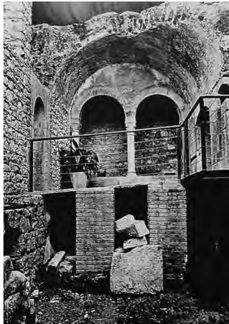
FIGURA 43. Banys de Girona. El caldari amb les estructures inferiors durant les obres de restauració de 1929-1935.
