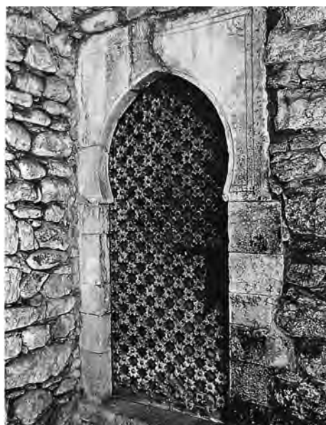
FIGURA 45. Banys de Girona. La porta entre el cel obert i la claveguera durant les obres de restauració de 1929-1935.
