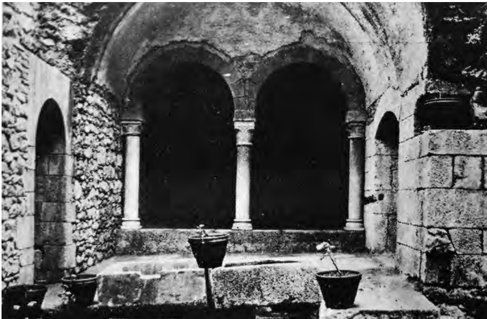
FIGURA 39. Banys de Girona. El caldari durant les obres de restauració de 1929-1935.
