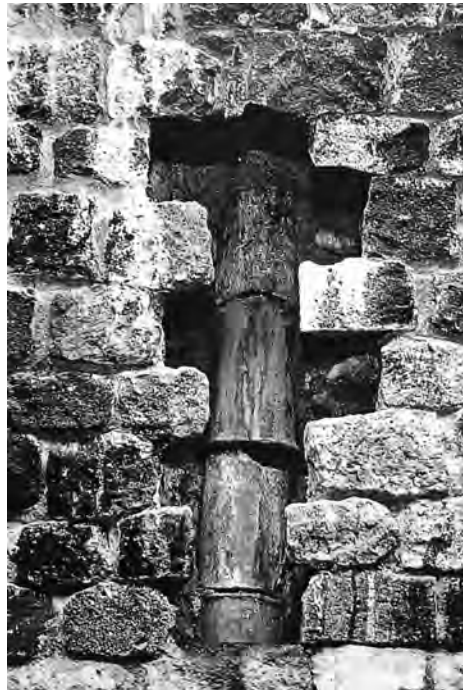
FIGURA 48. Banys de Girona. Canalera de ceràmica vidriada situada al mur de tramuntana del caldari per a la circulació de l'aire calent de l'hipocaust durant les obres de restauració de 1929-1935.
