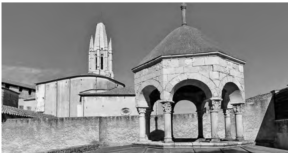
FIGURA 162. Banys de Girona. Vista exterior de la llanterna, els seus capitells amb l'església de Sant Feliu al fons, estat actual.
