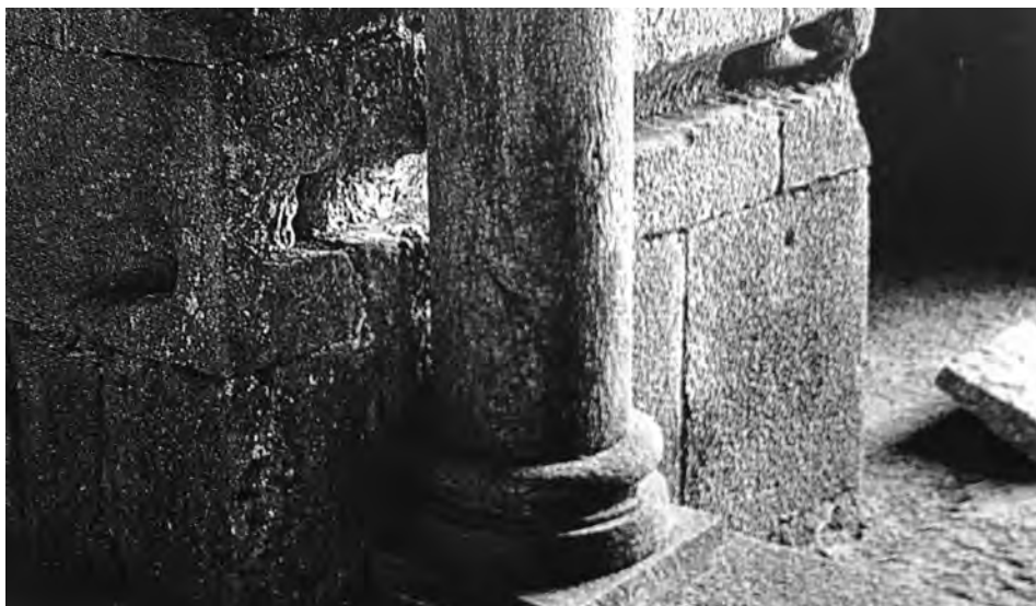
FIGURA 44. Banys de Girona. El mur sud del caldari amb la conducció mural d'aigua calenta cap a la piscina durant les obres de restauració de 1929-1935.
