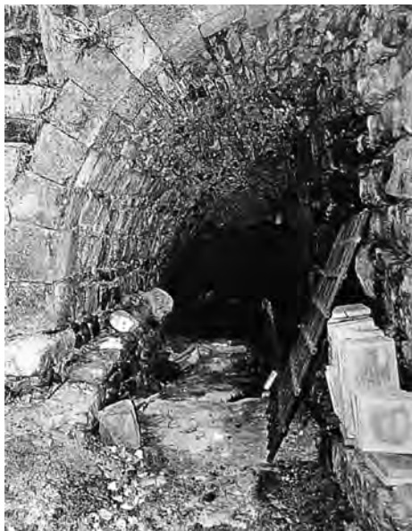
FIGURA 49. Banys de Girona. La clavoguera que condueix de la sala freda a l'exterior durant les obres de restauració de 1929-1935.
