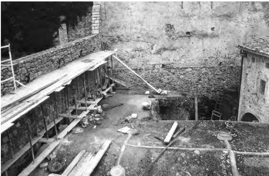
FIGURA 35. Banys de Girona. Fotografia de les obres de 1929-1935.
