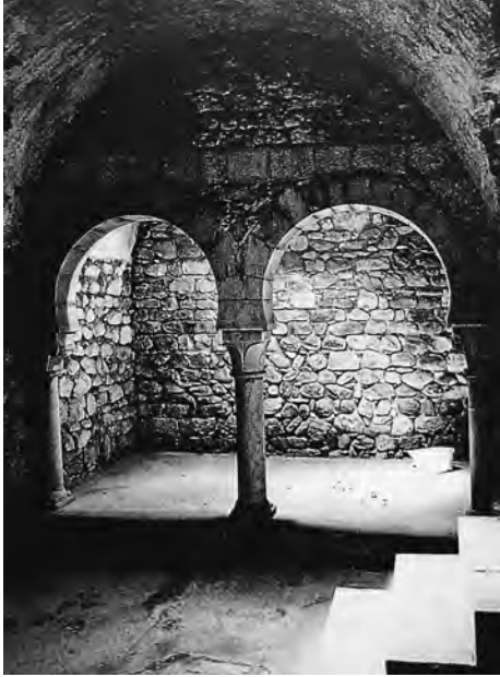
FIGURA 47. Banys de Girona. La sala freda amb alcova durant les obres de restauració de 1929-1935.
