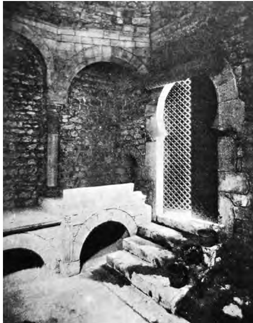
FIGURA 38. Banys de Girona. La porta de pas a la sala principal durant les restauracions de 1929-1935.
