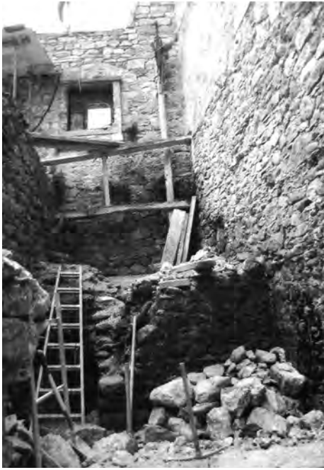
FIGURA 42. Banys de Girona. El pati annex al segon caldari durant les restauracions de 1929-1935.
