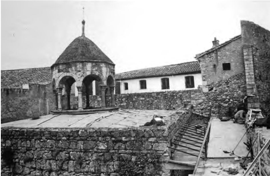
FIGURA 34. Banys de Girona. La llanterna de la sala principal i el terrat en obres durant les restauracions de 1929-1935.
